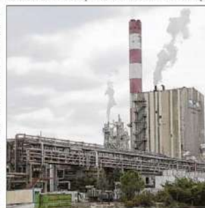
Fibre Excellence à Tarascon. À droite: le projet de Fibre Excellence fait partie des 11 nouveaux lauréats pour développer des installations de production d'électricité à partir de biomasse
